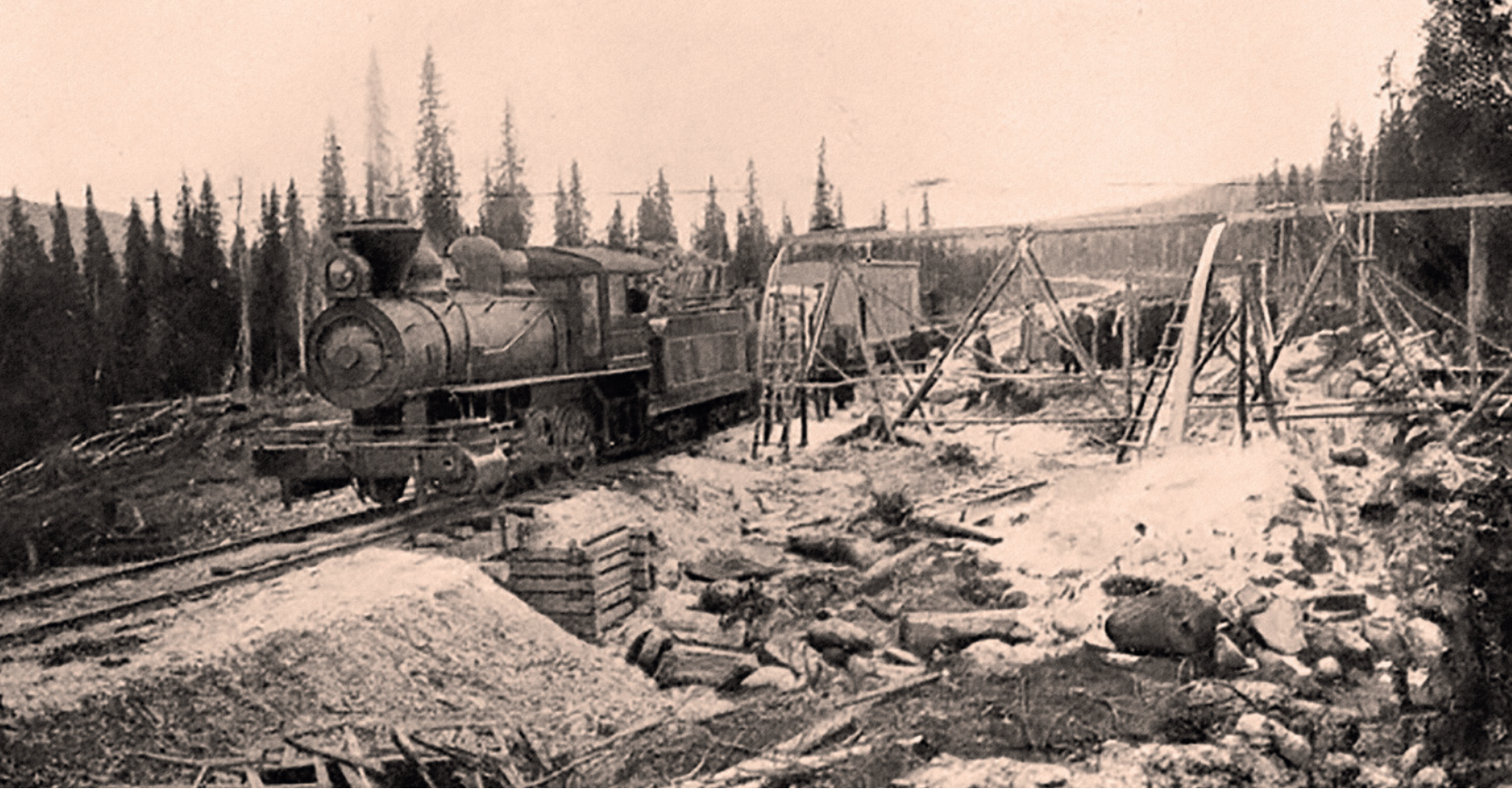
Один из построенных участков трассы Мурманской железной дороги 1916
